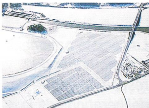
Der weltgrösste Solarpark steht zurzeit noch in der Gemeinde Mühlhausen im Landkreis Neu- markt (Bayern).
