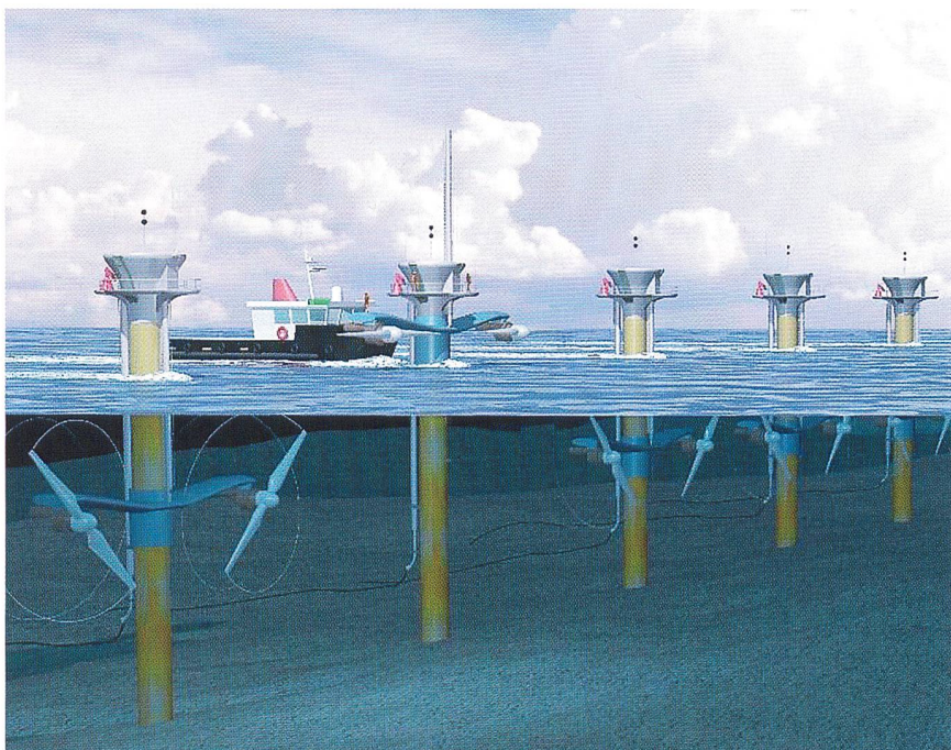
Projekt «Seagen» mit 1-MW-Doppelrotoranlagen (Marine Current Turbines).
