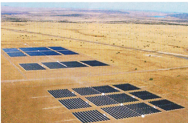
Grösste PV-Anlage der USA: Springerville in der Wüste bei Tucson, Arizona (35 000 Module/4,6 MW p ).
