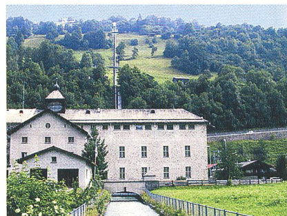
Zentrale Küblis: Nach der Turbinierung fliesst das Wasser über einen Unterwasserkanal in die Landquart zurück.
