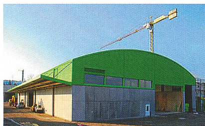
Biogasanlage Pratteln (Bild: iwB).
