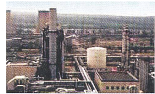
Kohlevergasungsanlage der Sustec.
