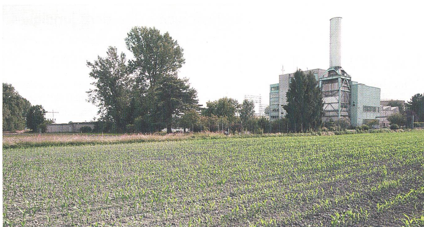
An diesem Standort plant Groupe E das neue Erdgas-Kombikraftwerk (Bild: Groupe E).
