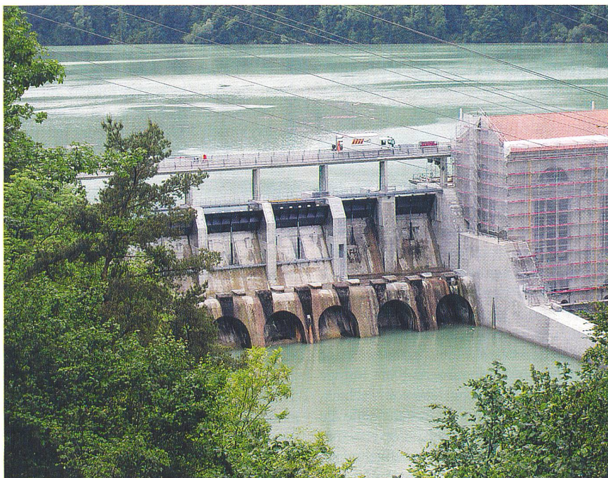
Wohlensee mit Brücke und Stauwehr des Kraftwerks Mühleberg (Bild: bkw).
