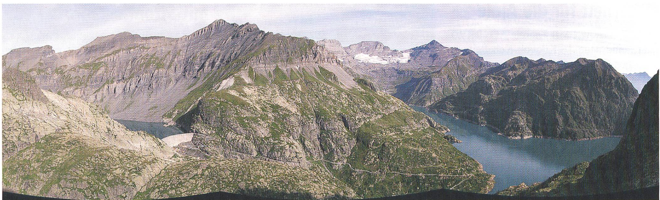
Links: Stausee Vieux Emosson, rechts: Stausee Emosson. Die neue Pumpspeichieranlage «Nant de Drance» wird in der Bildmitte zwischen den beiden Stauseen über 500 Meter tief im Fels gebaut (Bild: Atel).
