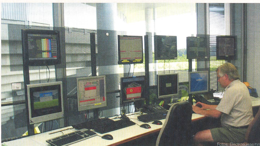
In der Kommandozone der MIB AG laufen alle Fäden des Wankdorf-Centers zusammen. Es besteht ein 24-Stunden-Pikettdienst; die Alarmierung erfolgt automatisch auf Pager. Foto: Electrosuisse/hm
