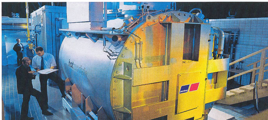
HotModule (mit bis zu 245 kW el und 170 kW th ) von MTU CFC Solutions.
