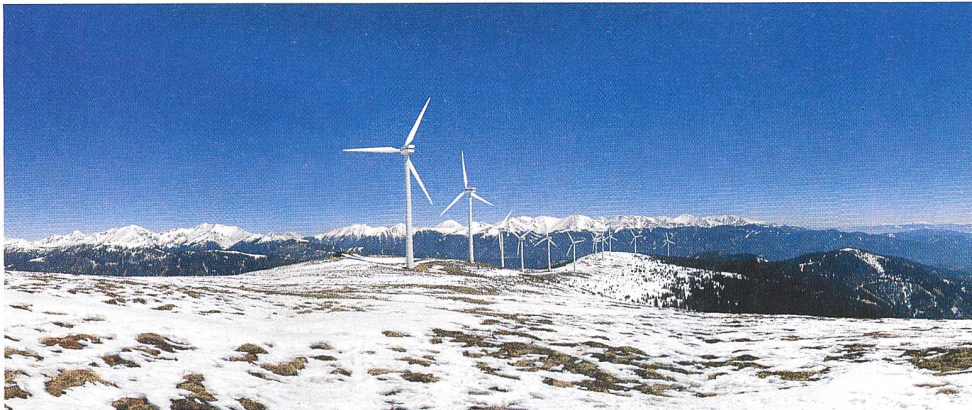
Tauernwindpark (Bild igw).
