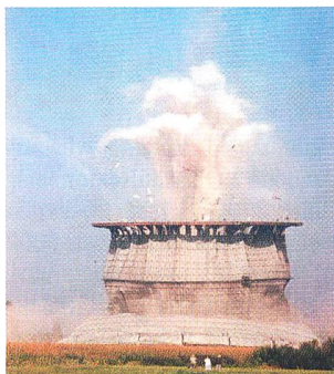
Sprengung des Trockenkühlturms des Thorium-Hochtemperaturreaktors (THTR) in Hamm-Schmehausen (1991): kommt nun die Renaissance?
