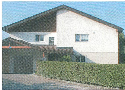
In diesem älteren Einfamilienhaus im sankt-galischen Muolen wurde die Ölheizung durch eine Wärmepumpe mit einer Heizleistung von rund 10 Kilowatt ersetzt
