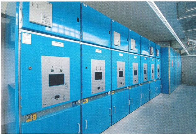
Die PIX-C-Mittelspannungs-Schaltanlage.
