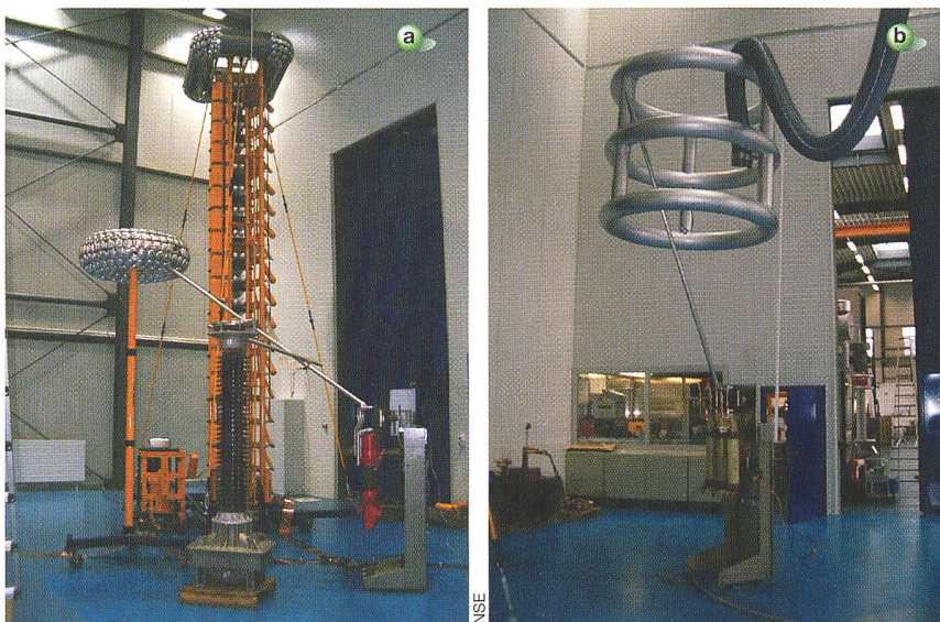
Bild 7 Prüfungen des Schalters für 12/24 kV
