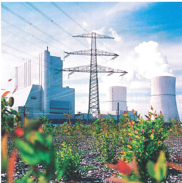
Neu erstelltes, modernes 1600-MW-Kohlekraftwerk «Schwarze Pumpe» (Brandenburg/D). Am 29. Mai 2006 wurde im Industriegebiet Schwarze Pumpe auch der Grundstein für das weltweit erste CO 2 -freie Kohlekraftwerk gelegt (Bild Siemens).
