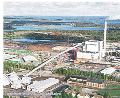
Centrale de production d'énergie renouvelable en Finlande (foto Oy Alholmens Kraft AB).
