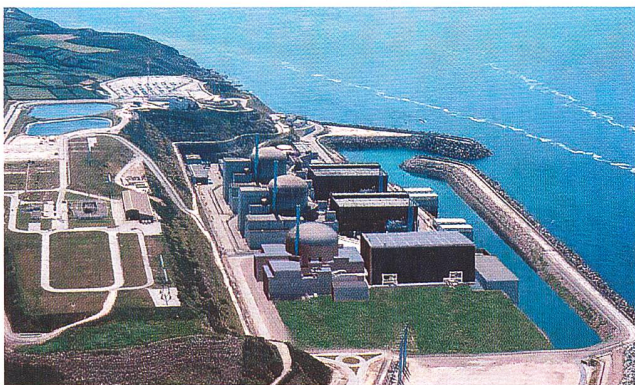
Kernkraftwerk Flamanville in der Normandie (Photomontage: im Vordergrund der EPR).
