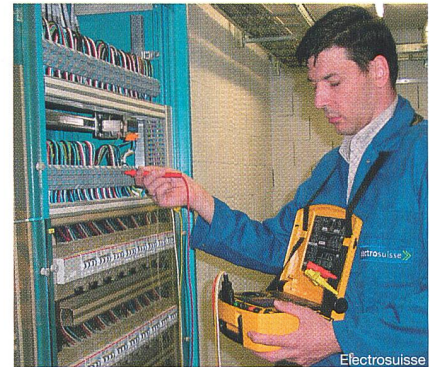
Figure 1 Contrôle final selon les normes sur les installations à basse tension
