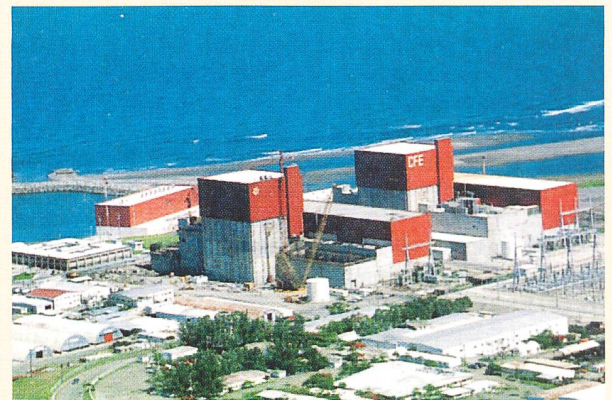
Bereits in Betrieb: zwei Kernkraftwerke (2x680 MW) in Laguna Verde.
