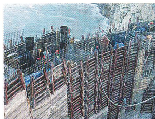
HydroOGK-Wasserkraftwerk Gunib in Bau.
