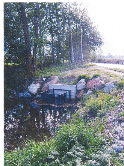
Mit einem sogenannten Düker wird das Wasser aus dem renaturierten Gebiet fischgängig unter dem Poschiavino durchgeleitet (Bild: Rätia).
