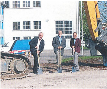
Der Spatenstich wird ausgeführt von Architekt U. Hauri, Projektleiter H. Roth und P. Hugentobler, Leiter Netzinfrastruktur (von links nach rechts). Im Hintergrund das zu ersetzende bestehende Unterwerk (Bild: aew).
