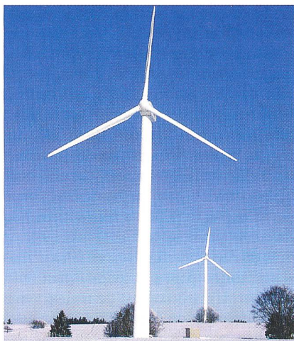
Die Windenergie im Jura könnte um das Zwei- bis Dreifache erhöht werden (Bild: suisse-eole).
