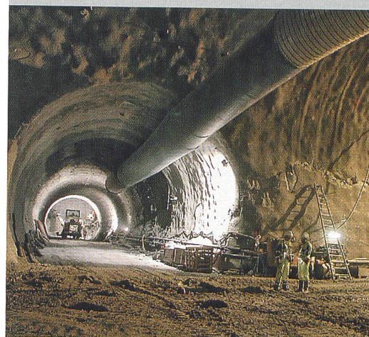
Neat-Tunnel bei Faido: Auch der Gotthard-Basistunnel wird auf geothermische Quellen untersucht.
