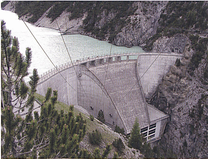
Figure 2 Barrage de Ova Spin avec une hauteur de 73 m et la centrale de Ova Spin avec une puissance installée de 50 MW (turbine) resp. 47 MW (pompe) (Photo G. Werro).
