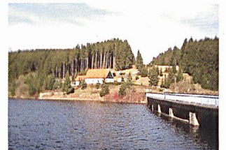
Talsperre in Königshütte (D).
