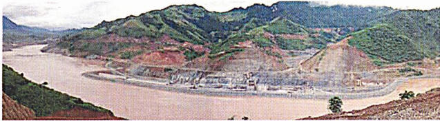
Flussumleitung während des Baus der temporären Betondurchlässe (Bild Colenco).
