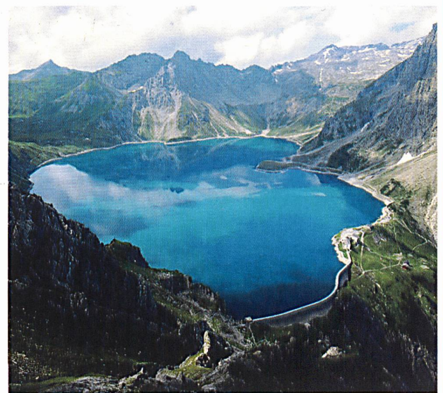
Lünensee mit Staumauer (Vorarlberg, Bild Lünenseebahn).
