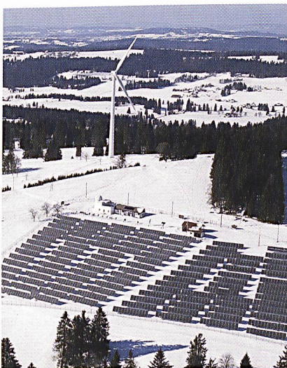
Sonnenkraftanlage auf dem Mont-Soleil im Jura (Bild: bkw).
