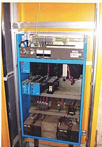
Eine wunderbare Notlichtanlage – leider sind die Leuchten nicht angeschlossen. Ein Test hätte dies sofort gezeigt.
