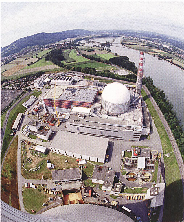
Das Kernkraftwerk Gösgen wurde innert zehn Jahren gebaut (Bild KKG).
