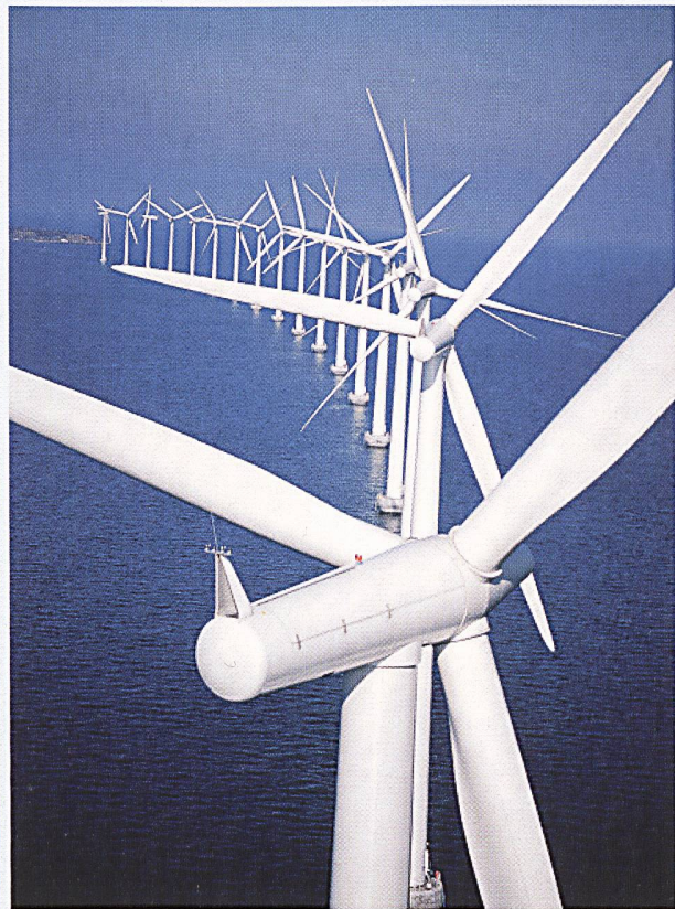
Windpark mit 20 Rotoren (zu je 2 MW) vor der niederländischen Küste (Bild LM Glasfiber).
