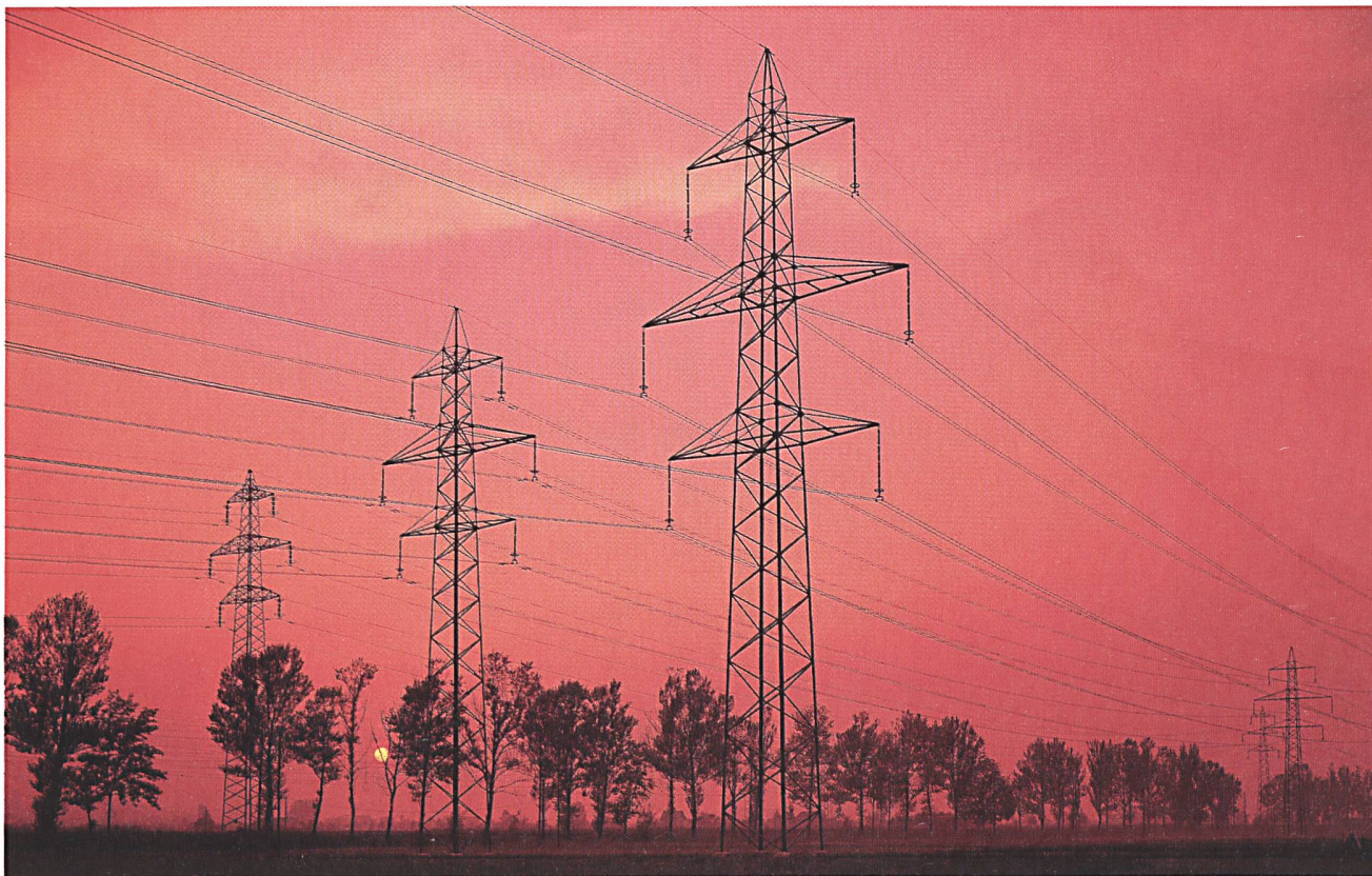
Das oberste Ziel ist die sichere, wirtschaftliche und umweltverträgliche Stromversorgung des Landes (Bild: Axpo).
