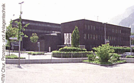
Bild 1 Ansicht des Gebäudes der HTW Chur.
