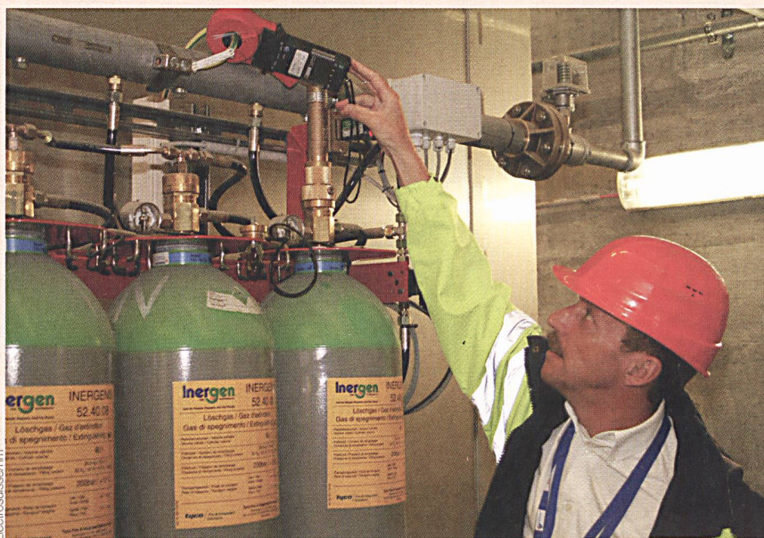
Erdschlaufenmessung an einer Löschanlage.
