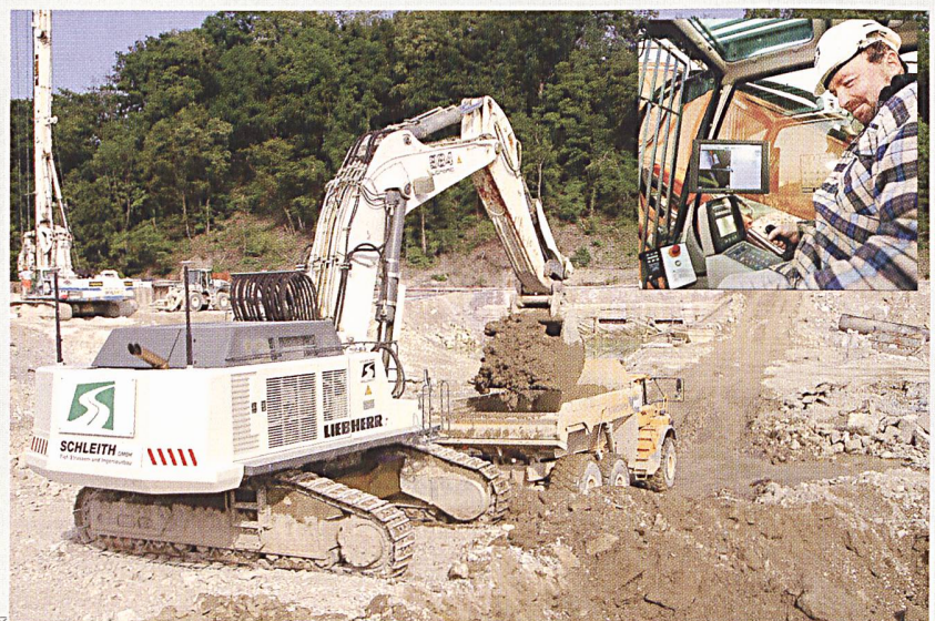
Dank dem GPS-System muss der Baggerfahrer nur noch das Auf- und Abladen mit der Schaufel steuern. Hinten auf dem 133 Tonnen schweren Bagger sieht man deutlich die Antennen für den Empfang.
