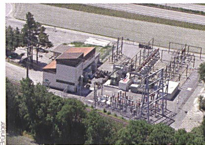
Der Bau eines Unterwerks ist ein anspruchsvolles Vorhaben.
