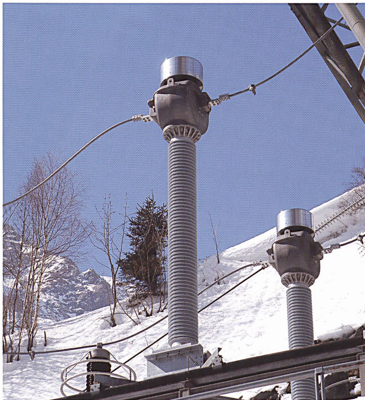
Energie Electricque du Simplon SA
