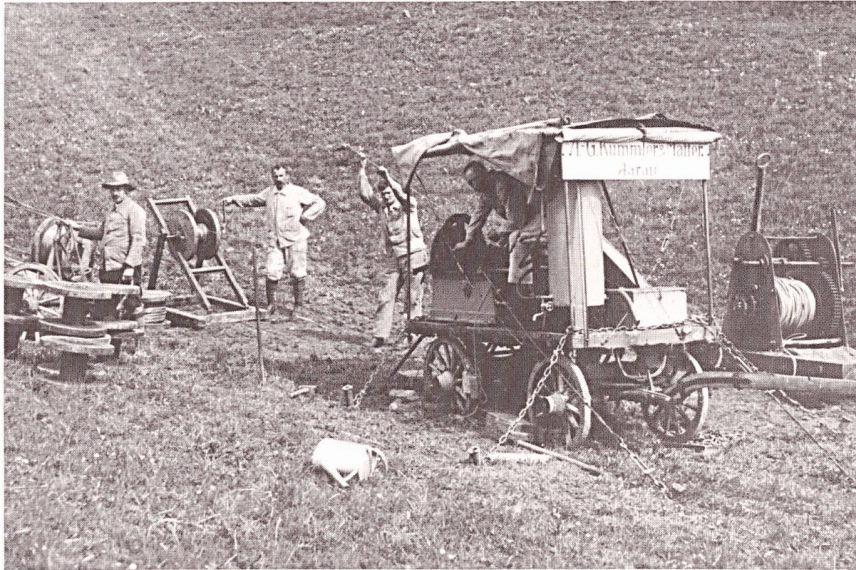
Bild 3 Pferdefuhrwerk mit Leitungsseil-Zugseinrichtung, deren Kraftquelle nicht identifizierbar ist. Genügte die Handwinde? Weder für den Leitungsseil-Einzug noch für den Mastaufzug finden sich Ausführungen zur Zugkraftquelle.
