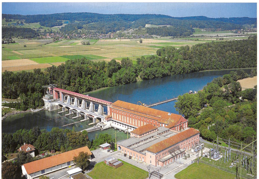
Das Kraftwerk Eglisau-Glattfelden AG aus der Vogelperspektive.
