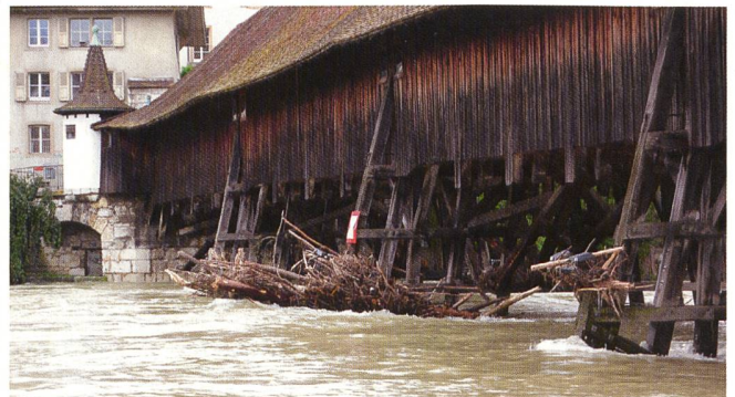
Schwemmholz an der alten Holzbrücke in Olten am 10. August 2007.
