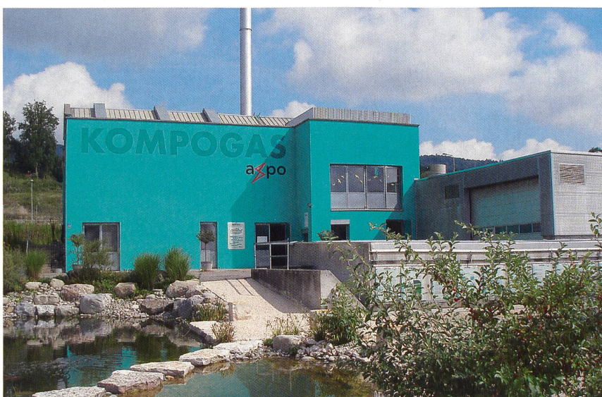
Bild 1 Kompogas-Anlage in Otelfingen.
