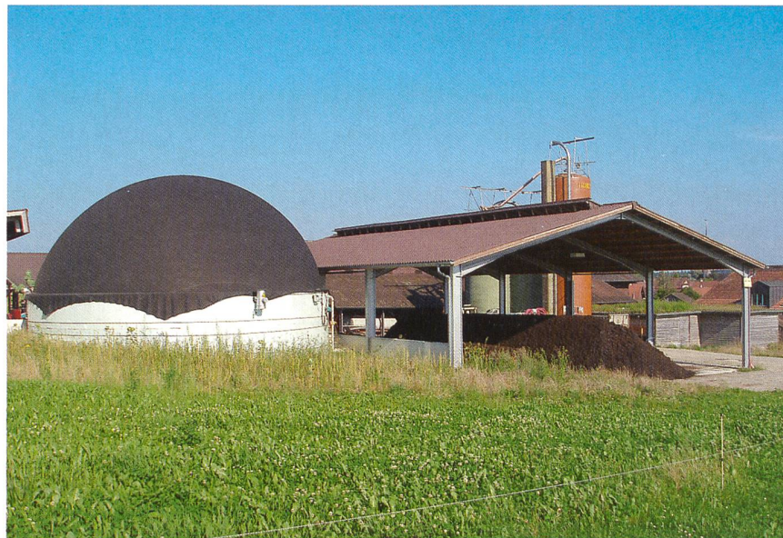
Bild 2 Landwirtschaftliche Biogasanlage mit Co-Vergärung und Nachkompostierung.
