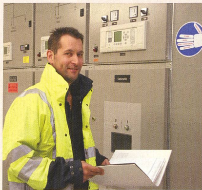
Oben: Andreas Quinz – vor der Mittelspannungsanlage in der Zentrale Reppischtal – gehört zum Inspektorenteam von Electrosuisse, das in der Westumfahrung tätig ist.
