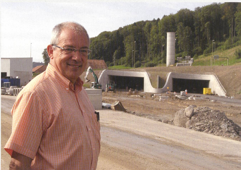
Zwischenhalt auf dem Weg zum Üetlibergtunnel. Roland Röllin vor dem Portal des Isisbergtunnels. Gut sichtbar der Kamin, über den im Brandfall der Rauch ins Freie befördert würde. Der Isisbergtunnel wird im November 2009 dem Verkehr übergeben und führt via Knonaueramt in die Zentralschweiz.
