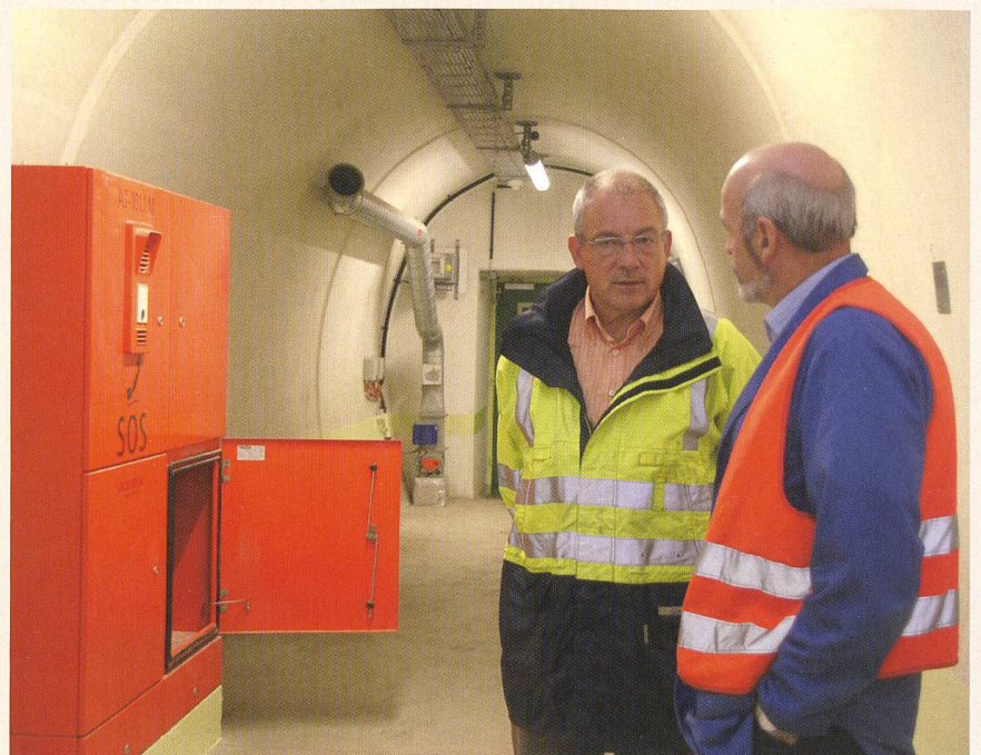
Spontanes Gespräch unter Fachleuten in einem Querschlag des Üetlibergtunnels: Roland Röllin unterhält sich mit Heinz Burkard, zuständig für die Schlusskontrolle der Elektroinstallationsunternehmung.
