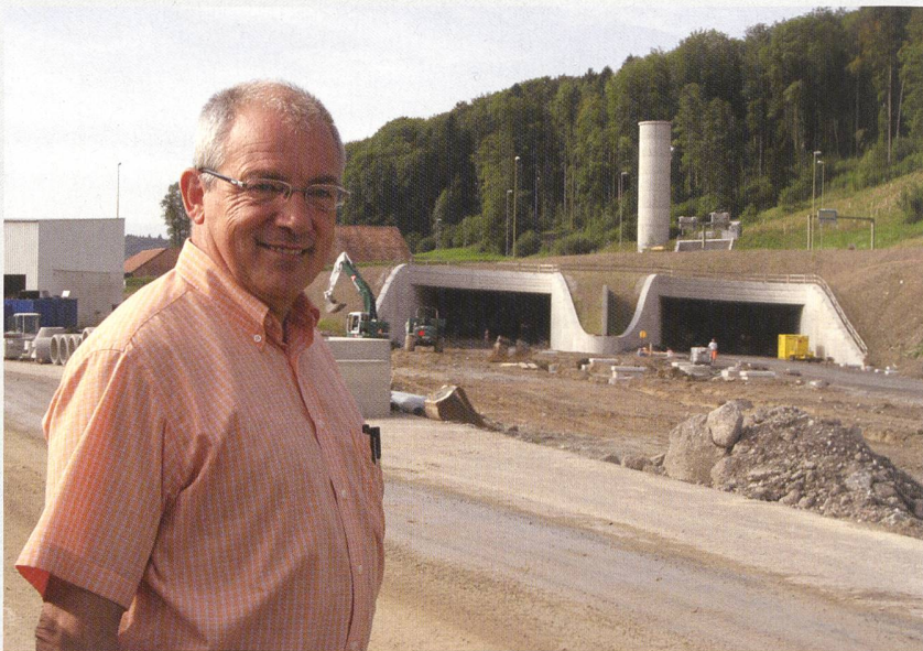
Zwischenhalt auf dem Weg zum Üetlibergtunnel. Roland Röllin vor dem Portal des Isisbergtunnels. Gut sichtbar der Kamin, über den im Brandfall der Rauch ins Freie befördert würde. Der Isisbergtunnel wird im November 2009 dem Verkehr übergeben und führt via Knonaueramt in die Zentralschweiz.
