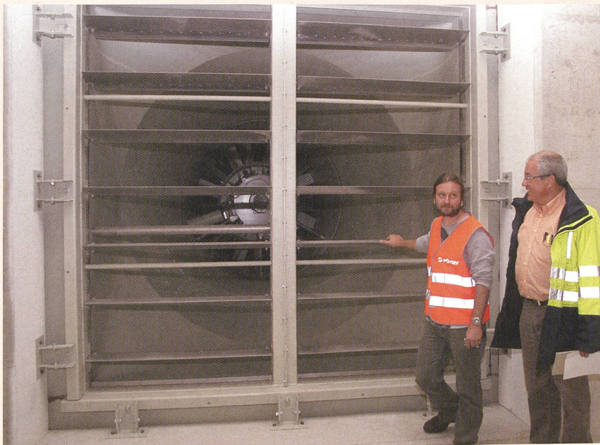
Oben: Fototermin vor einem der mächtigen Axialventilatoren in der Lüftungszentrale Reppischtal, die im Brandfall den Rauch durch den Tunnel (unten) via Kamin ins Freie befördern.
