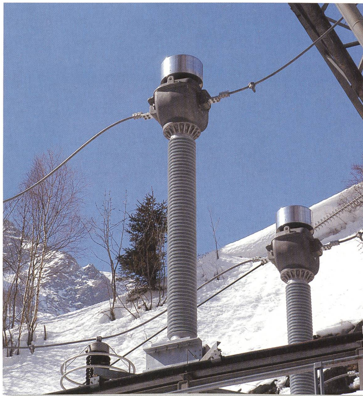
Energie Electricque du Simplon SA
