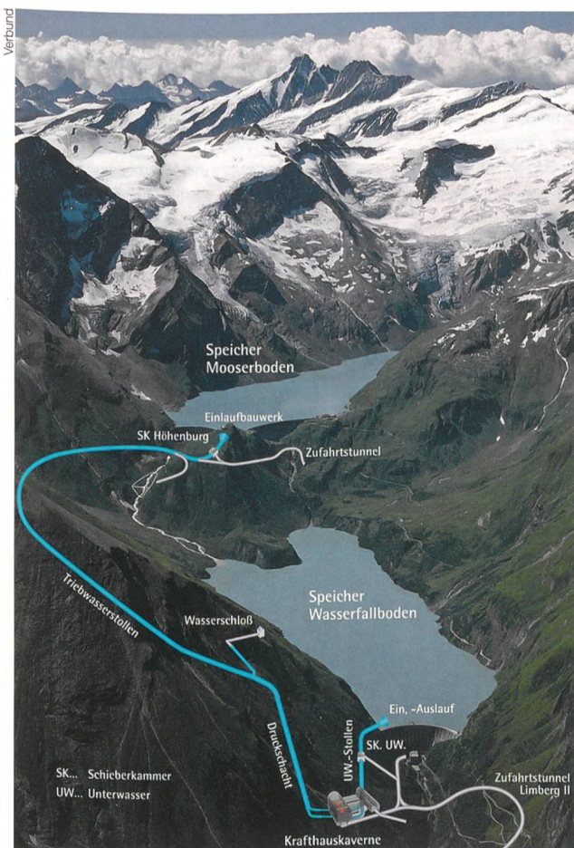
Bild 5 Übersicht Pumpspeicherkraftwerk Limberg I.
