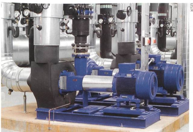
Bild 1 Klassische Motor-Pumpe-Anordnung.
