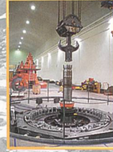
Kraftwerk-Retrofit und Neubau
