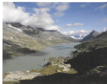
Die Staumauern des ältesten Schweizer Alpenstausees sollen erhöht werden.
