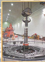
Kraftwerk-Retrofit und Neubau
