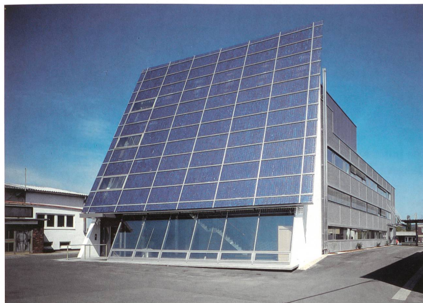
Bild 2 Eine in einem Industriegebäude integrierte FV-Anlage.
