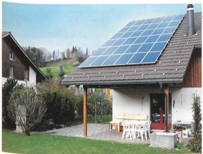
In Baselbieter Ortsbildern von lokaler und regionaler Bedeutung sollen neu Solaranlagen bewilligt werden.
