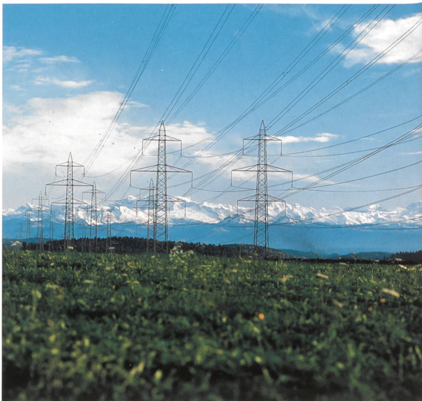
Der Bundesrat hat die strategisch wichtigsten Leitungsbauprojekte bis 2015 festgelegt.
