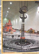
Kraftwerk-Retrofit und Neubau
