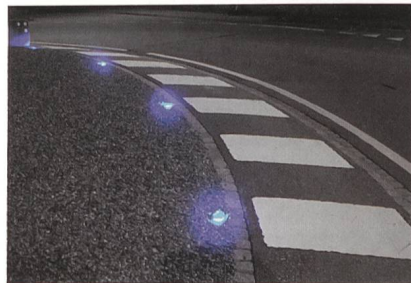
Circled-Einbauleuchten von Gifas sorgen für Sicherheit im Kreisverkehr.
