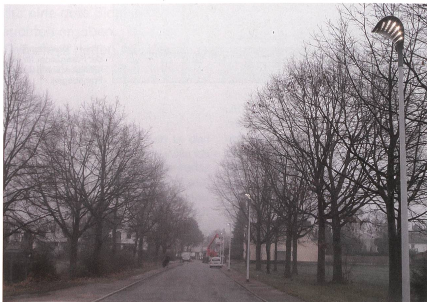
Bild 3 LED-Leuchte DL10 in der Teststrasse.
